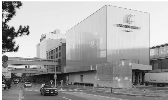
Le nouvel entrepôt à hauts rayonnages de Swissmill (construction en acier et verre) est équipé de cellules photovoltaïques.
